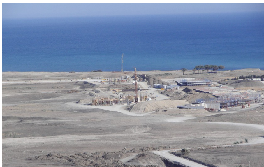
Durante i lavori (2006)
